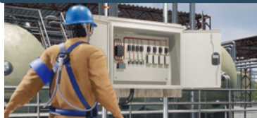
電源設備の管理を徹底する
