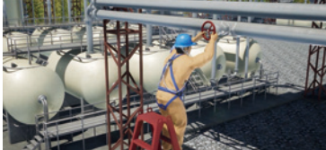
脚立の上での不安定な作業姿勢は、 転落事故につながる
